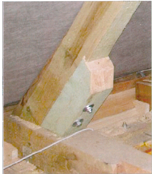
Bild 15: Teilerneuerung von Sparrenfuß und Balkenkopf mit neuer Fußverbindung über Rückversatz
