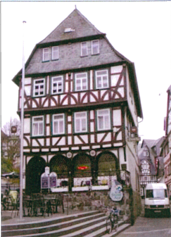
Bild 5: Schutz an einem durch Schlagregen hoch beanspruchten Dachgiebel
