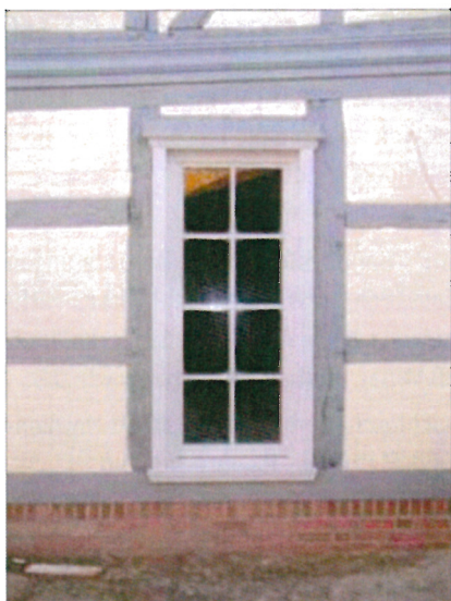
Bild 19: Neue Schwelle aus Eiche auf neuem Fundament nach Instandsetzung (rechts: Geschädigter Schwellenbereich vor der Instandsetzung)
