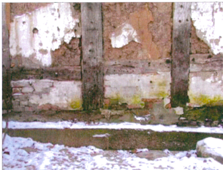
Bild 19: Neue Schwelle aus Eiche auf neuem Fundament nach Instandsetzung (rechts: Geschädigter Schwellenbereich vor der Instandsetzung)
